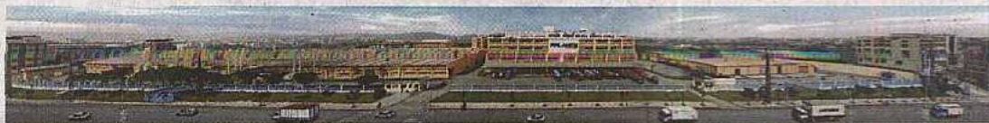
▲東莞塘廈的廠房佔地 10 萬平方米，設有 4 條自動化流水生產綫，足夠應付美時未來幾年的發展需要。
